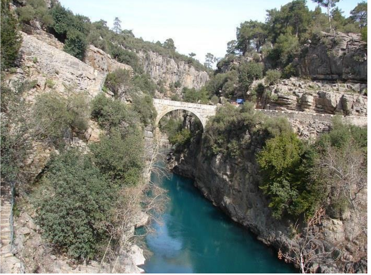
Selge Kemer Köprü
